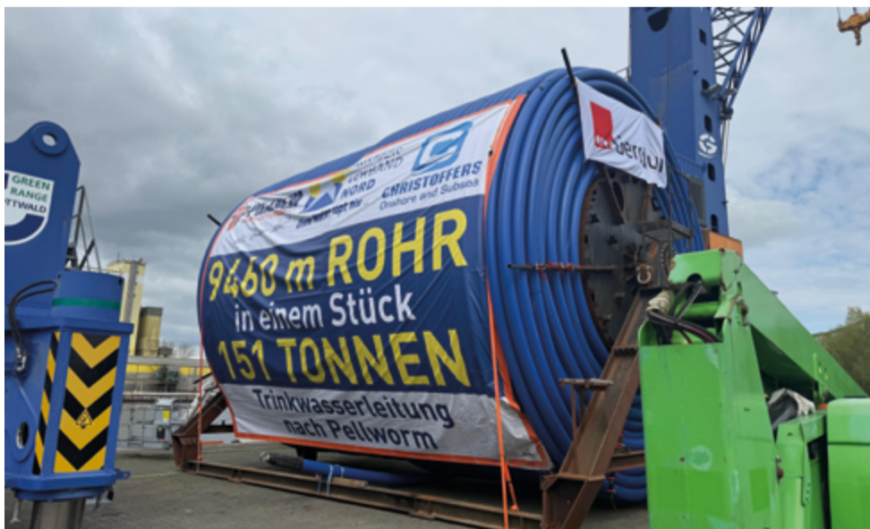
Der 9.500 Meter lange PE-Rohrstrang wurde im Hafen Rendsburg verschweißt und anschließend auf einer eigens für dieses Projekt konstruierten Großtrommel mit vier Metern Durchmesser und 11 Metern Breite aufgespult. Das Gesamtgewicht dieser Trommel betrug rund 160 Tonnen.
