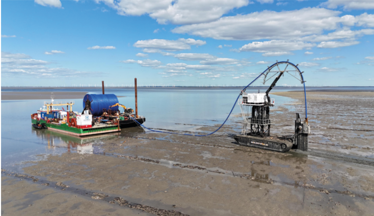
Unterhalb des sensiblen UNESCO-Weltnaturerbes Wattenmeer und des Nationalparks Schleswig-Holstein hat die Paasch Rohrleitungsbau GmbH eine rund zehn Kilometer lange Trinkwasserleitung als durchgehenden PE-Strang vom Festland zur Insel Pellworm verlegt. (Fotos: Paasch Rohrleitungsbau GmbH)
