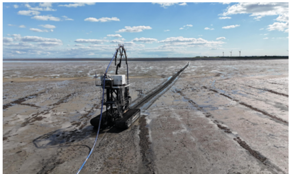
Die Leitung wurde mithilfe des Verlegefahrzeugs „Nessie“ in den Meeresboden eingebracht. Das kettengetriebene Gerät fräste einen schmalen Kanal, in den der Leitungsstrang abschnittsweise eingezogen wurde.
