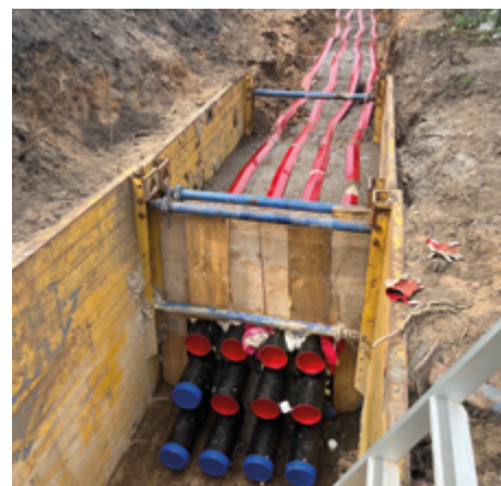
Schott zur Begrenzung eines Verfüllabschnitts beim Einbau von ZFSV. (Lupp Netzbau GmbH)
