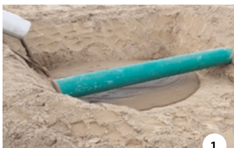
Beispielhafter Ablauf einer schrittweisen Verfüllung mit ZFSV. Mit zunehmender Füllhöhe steigt der ZFSV-Spiegel um die Rohrleitung an.
