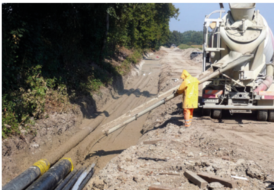
Mehrsparren-Streckenverfüllung
