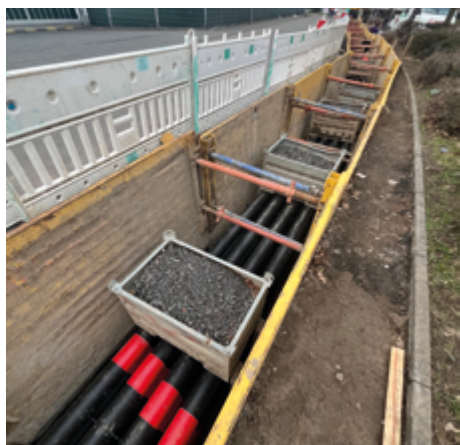
Beispiel einer einfachen mechanischen Auftriebssicherung zur Lagefixierung von Leitungen während des Einbaus von ZFSV. (Lupp Netzbau GmbH)
