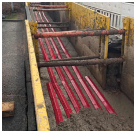
Mehrlagiger Einbau von ZFSV – nach dem Abbinden der unteren Lage wird der Bereich oberhalb der Kabelabdeckung weiter verfüllt. (Lupp Netzbau GmbH)
