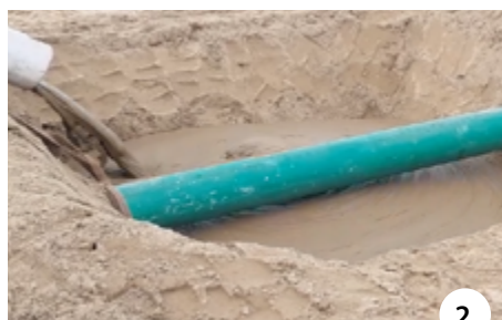
Beispielhafter Ablauf einer schrittweisen Verfüllung mit ZFSV. Mit zunehmender Füllhöhe steigt der ZFSV-Spiegel um die Rohrleitung an.
