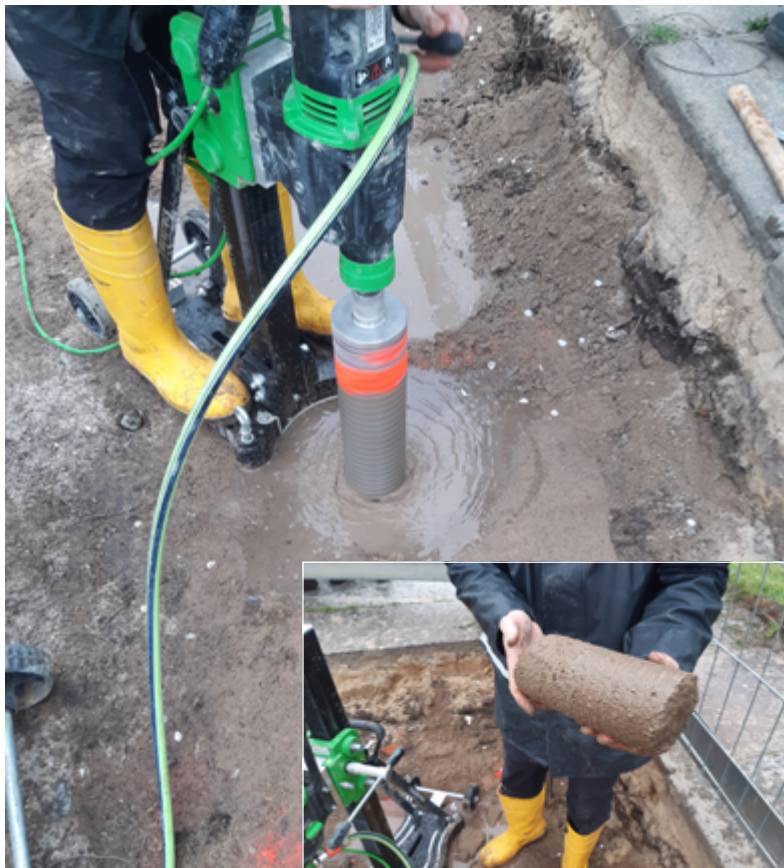
Probenahme am eingebauten ZFSV und entnommener Prüfkörper zur Qualitätssicherung (Quelle: OTH Regensburg/Labor für Geotechnik)
