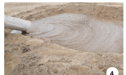
Beispielhafter Ablauf einer schrittweisen Verfüllung mit ZFSV. Mit zunehmender Füllhöhe steigt der ZFSV-Spiegel um die Rohrleitung an.
