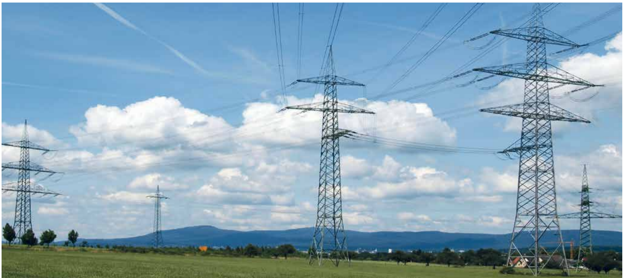
Lange galt die Überlandtrasse im Netzausbau als erste Wahl – das könnte sich jetzt ändern.
