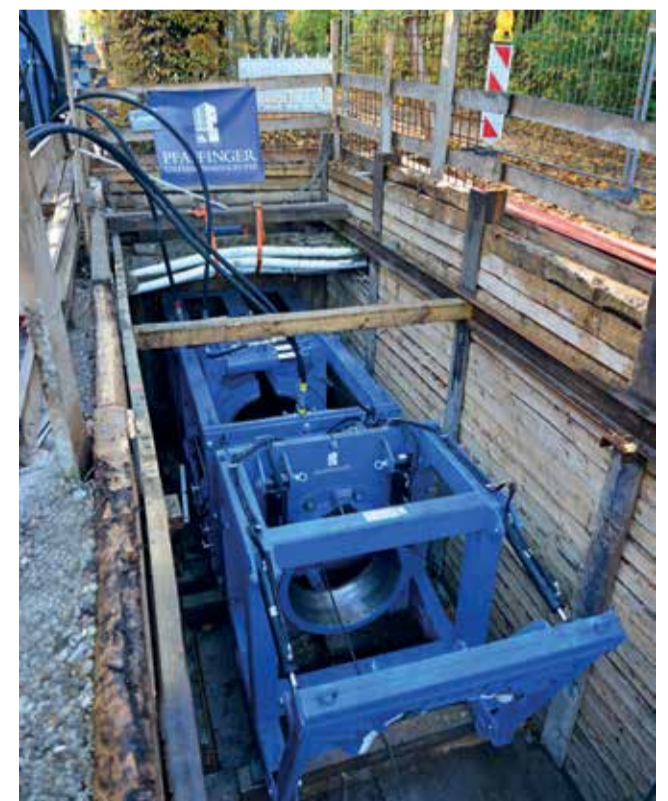
Premiere: Bei der Sanierung eines Dükers unter der Isar setzte Pfaffinger eine im Unternehmen entwickelte Einschubvorrichtung ein.
